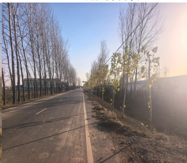
厂区外东侧道路
