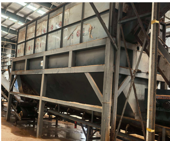
生产车间现状
