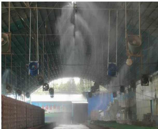
装卸砖区域喷淋抑尘
