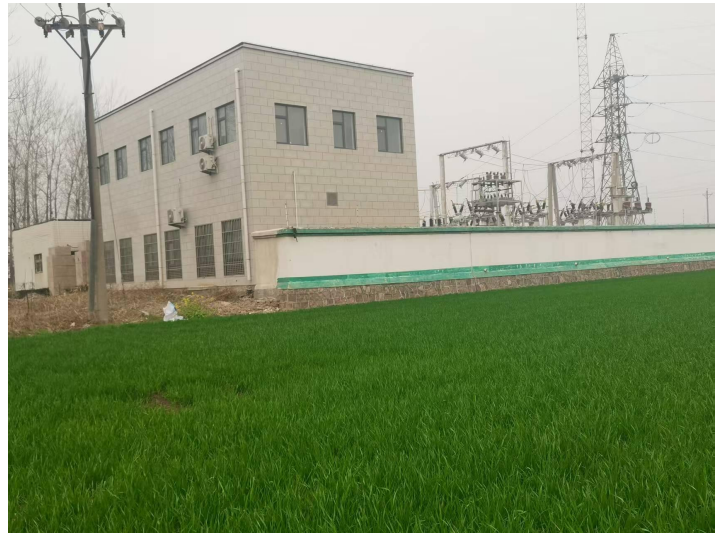
西侧隔农田为变电站
