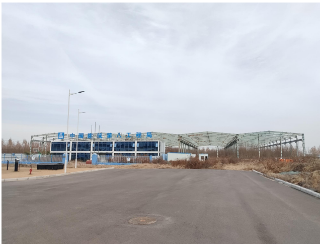
北侧建设厂房工地
