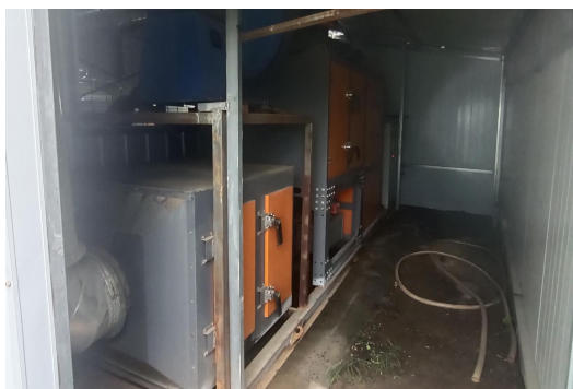
废气处理措施
