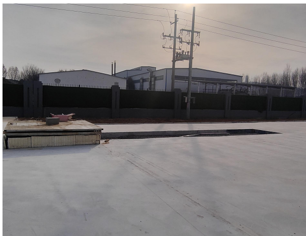
事故及初期雨水池
