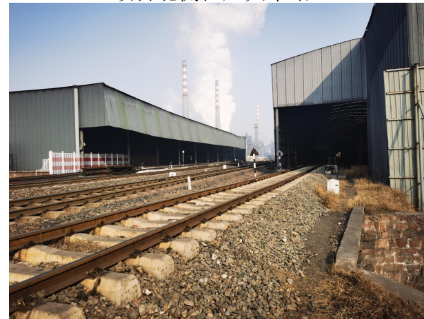
项目西侧铁路
