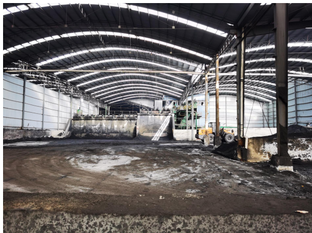
项目现有车间现状
