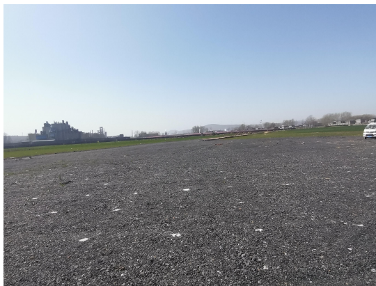
项目选址地面现状
