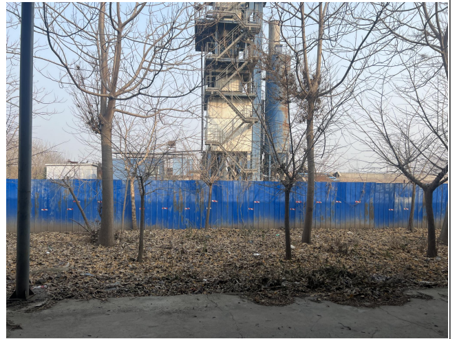
项目北侧紧邻废弃搅拌站
