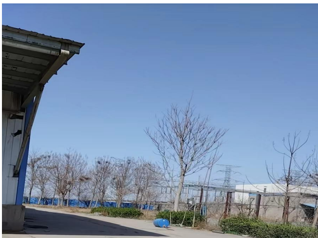
项目东侧百世腾饲料现有厂房
