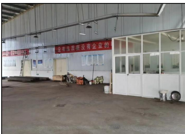
车间内部现状
