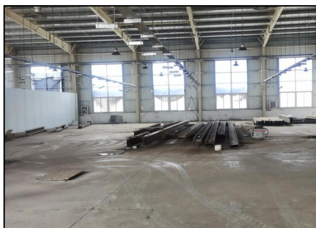
车间内部现状
