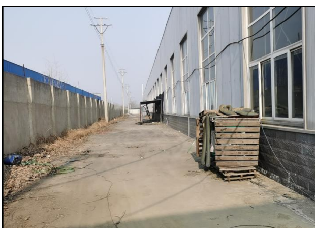
车间西侧现状
