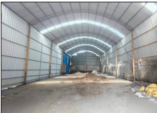
生产车间现状
