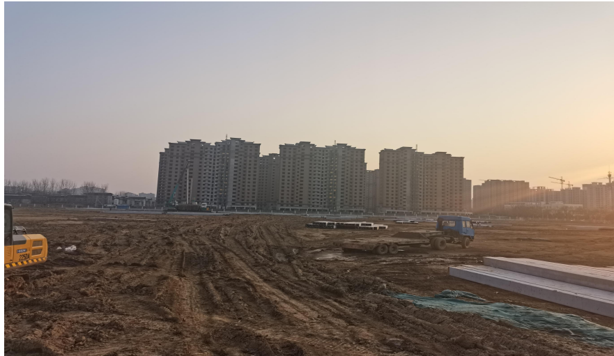
厂区南侧在建小区
