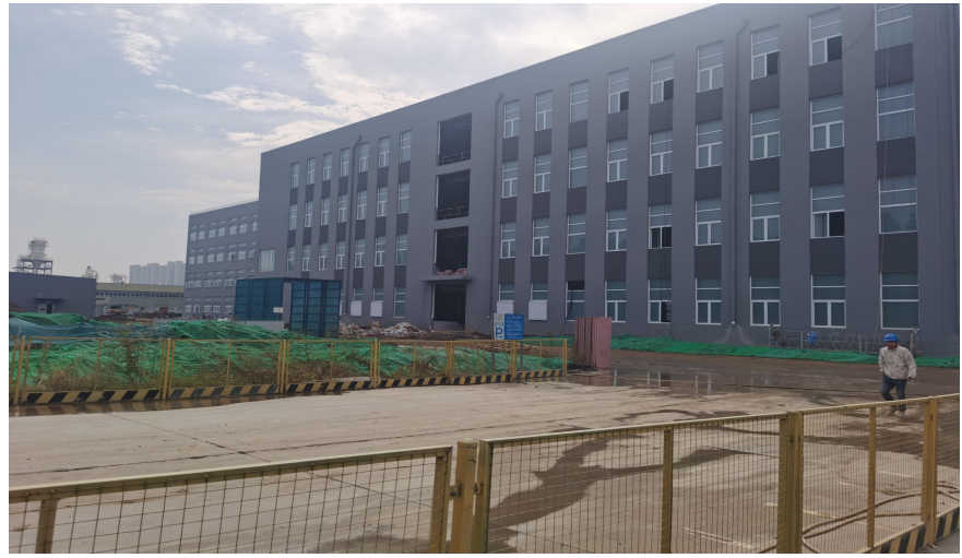
厂区现状照片
