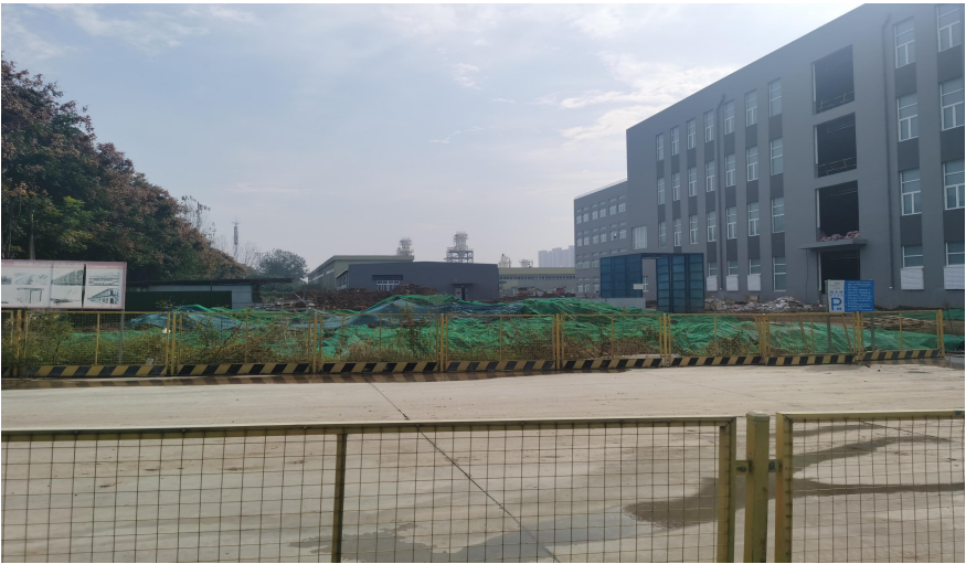
厂区现状照片
