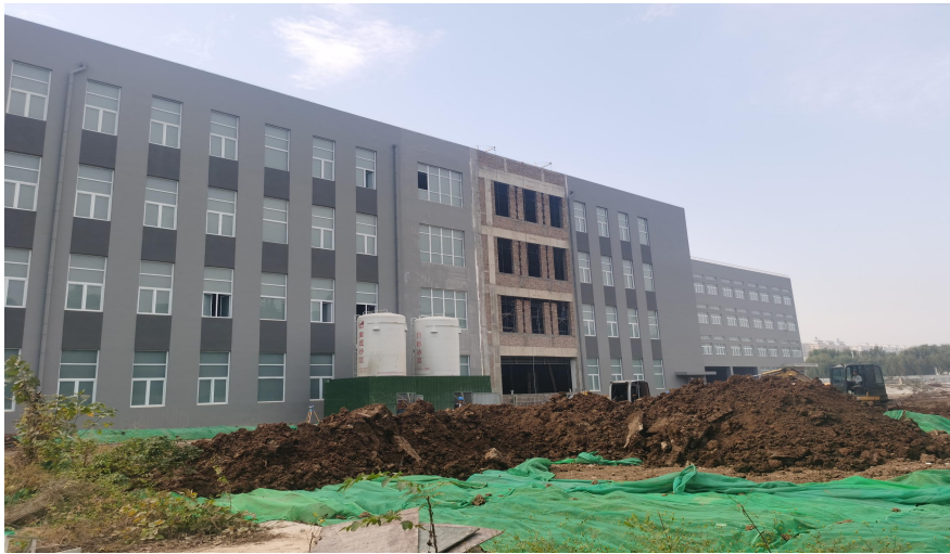
厂区现状照片
