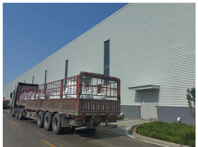
项目西侧安彩车间
