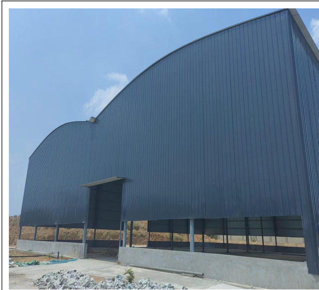
项目车间现状
