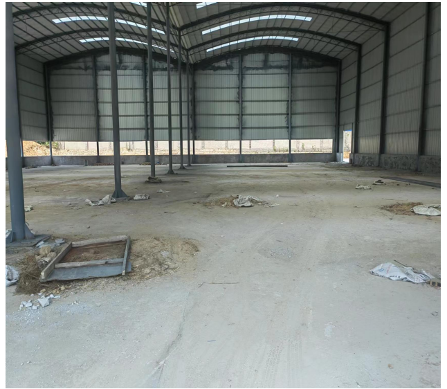
项目车间现状
