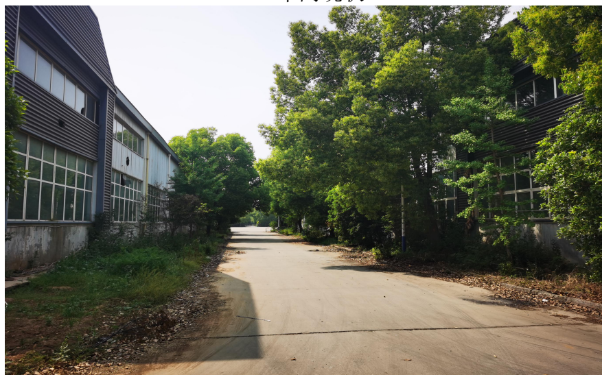
车间北侧现状
