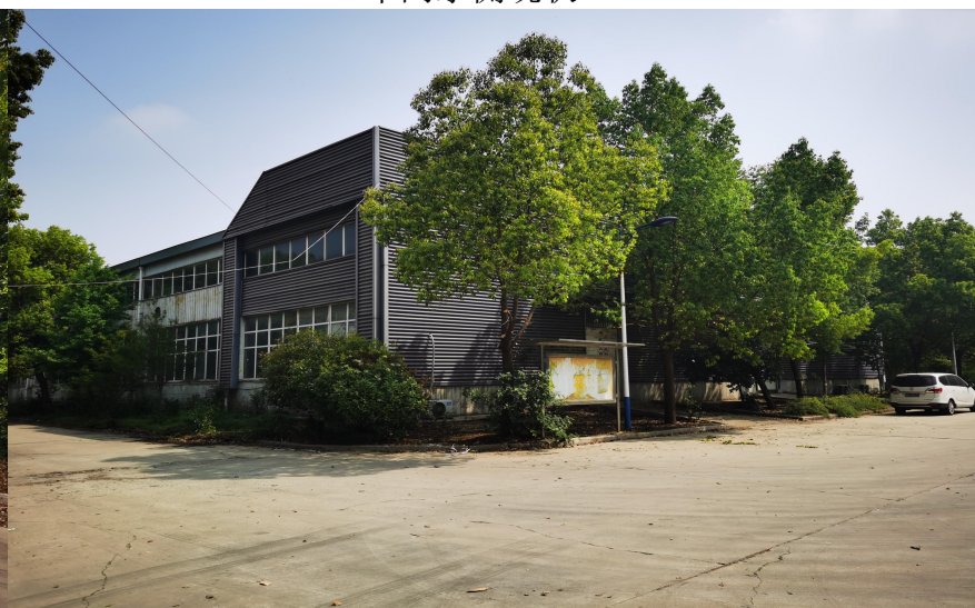
车间西侧现状
