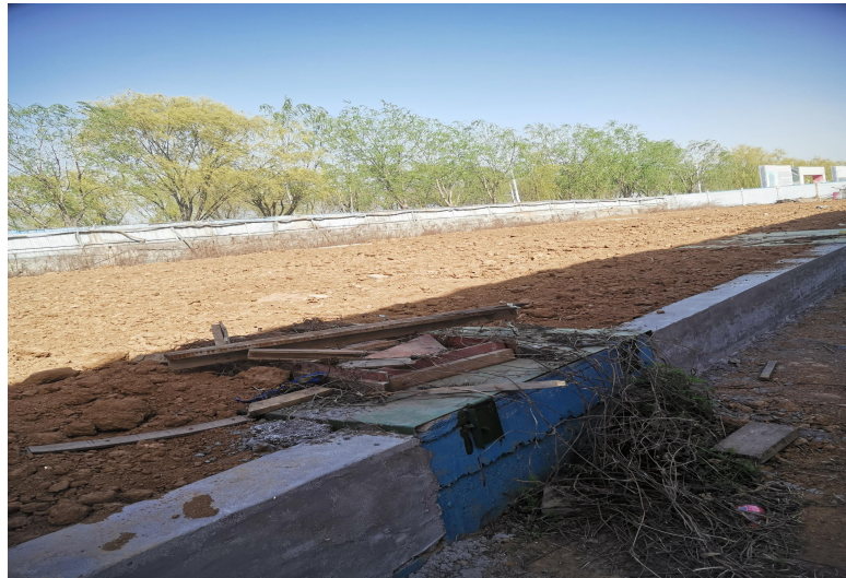
院区地埋式污水处理站
