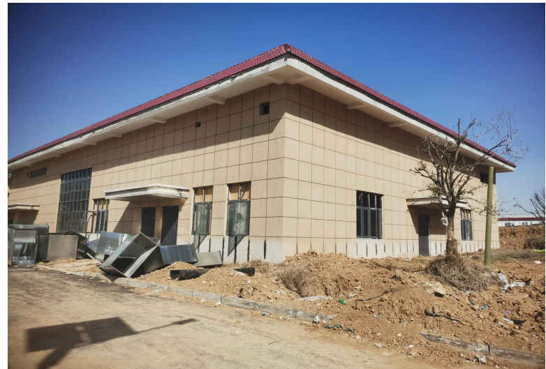
锅炉房现状照片
