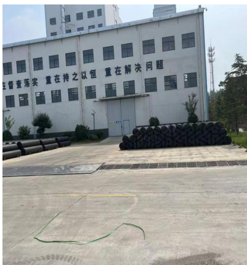
污水站东侧 (河南福兴新材料科技有限公司厂房)
