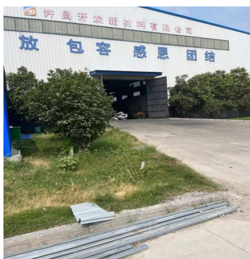
污水站西侧 (现有项目成品仓库)
