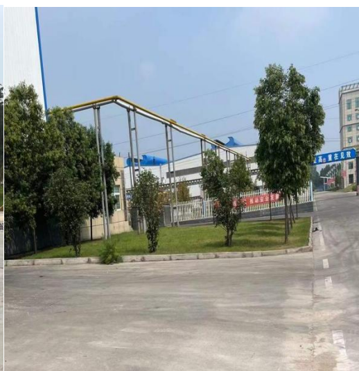
污水站北侧 (河南福兴新材料科技有限公司厂区)
