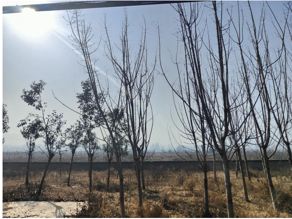
项目勘查井场现状照片（3）
