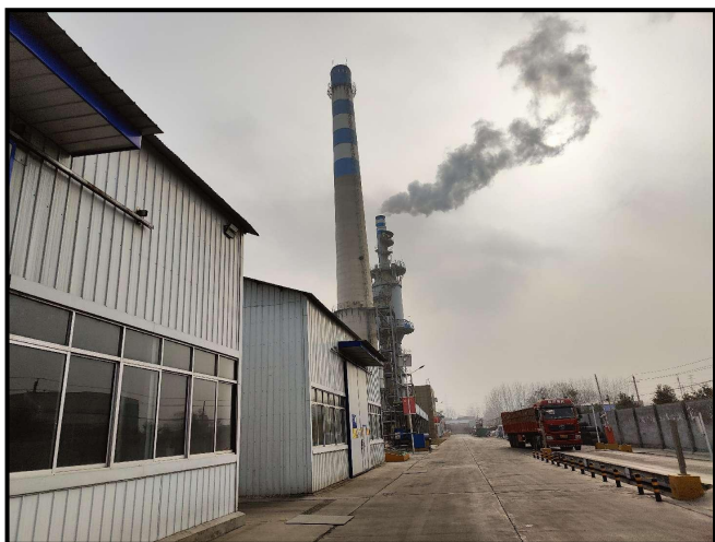
拟建负极板机加工车间、现有危废间以及 主要排放口脱硫湿电一体塔（由左至右）
