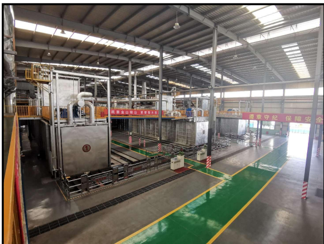
二烧车间隧道窑
