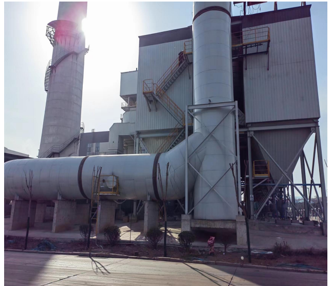
项目南侧光伏玻璃项目
