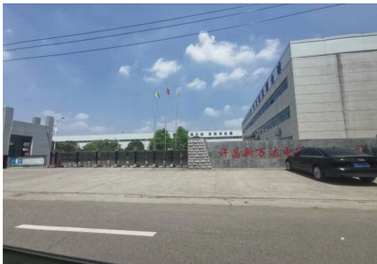
厂区外东侧新万达电缆
