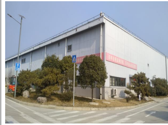
现有二车间厂房
