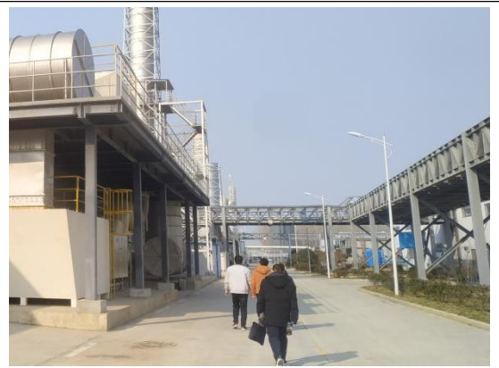
现场勘查照片
